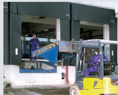
Демонтирайте старата товаро-разтоварна рампа, като евентуално адаптирате изкопа (напр. с монтажни плочи или конзоли)
